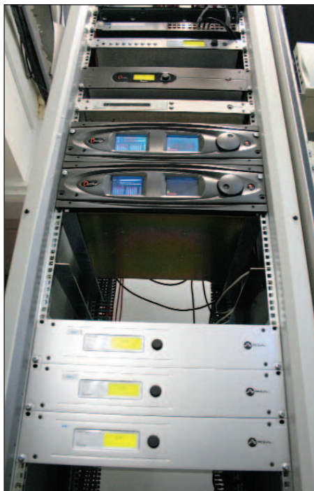
Baie Audio avec matériel Axia et Cisco
